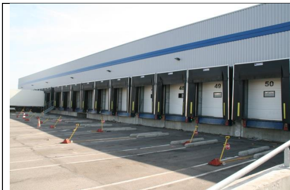
a) Façade Nord
